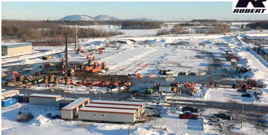
Le chantier du projet sur le terrain acquis par Groupe Robert à Varennes.
