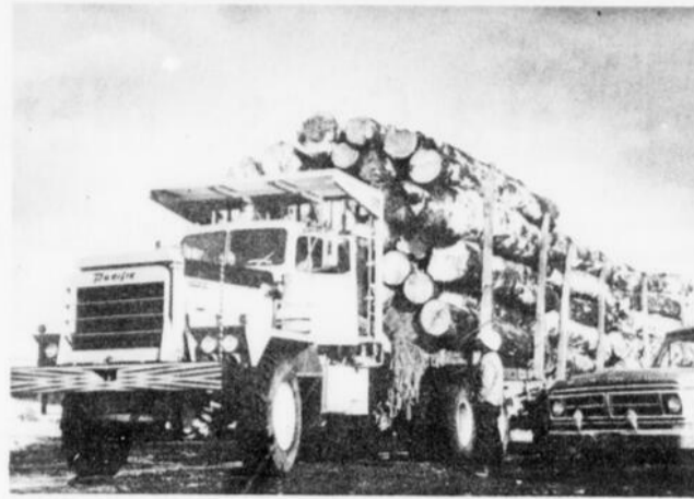
Camion de marque "Pacific" construit par International Harvester Co. de Vancouver C.B. en service à la sous-division Shipshaw de la Compagnie Price Limitée au nord de Chicoutimi. Sa charge utile est d'environ 18,000 p.m.p. soit entre 40 et 50 cordes.
