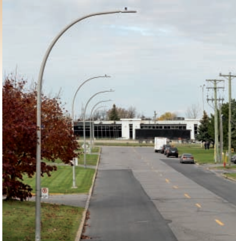
On reconnaît facilement les luminaires aux DEL à leur tête aplatie.
