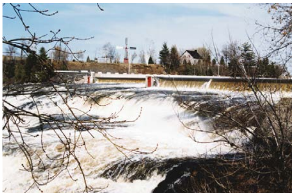
Barrage de Sainte-Brigitte-des-Saults sur la rivière Nicolet Sud-Ouest.
