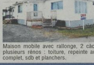
Maison mobile avec rallonge, 2 cdc, plusieurs rénos : toiture, repeinte au complet, sdb et planchers.
