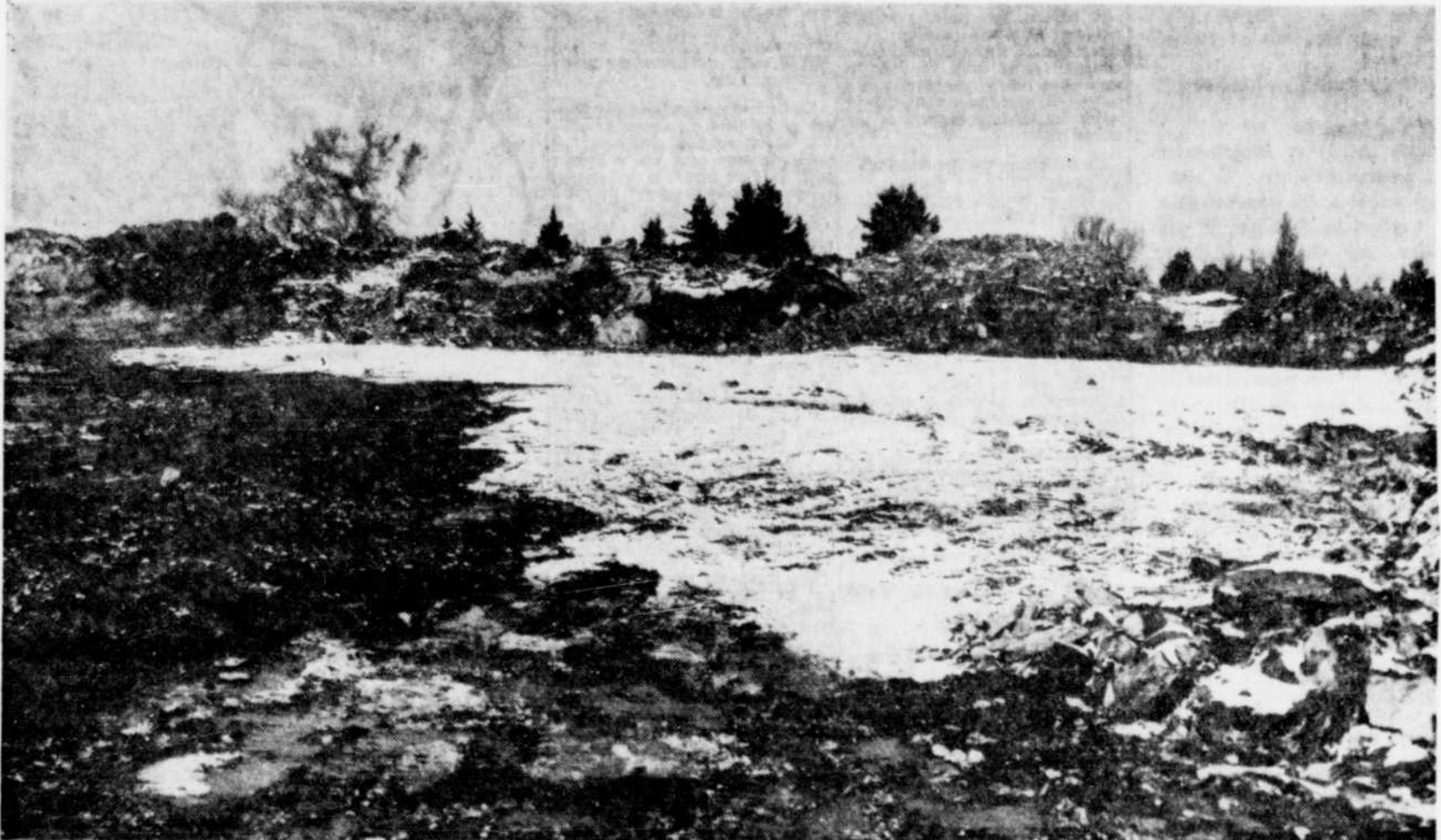
Le réservoir du quartier Nord aura 225 pieds de côté et une capacité de 5,000,000 de gallons. L'ingénieur Jacques Lemieux a expliqué qu'on achève d'enlever les 3,000 verges de roc et que le travail de béton commencera d'ici quelques jours. Les travaux sont surveillés par les ingénieurs Côté, Lemieux, Carignan et Bourque. (Photo "La Tribune")
