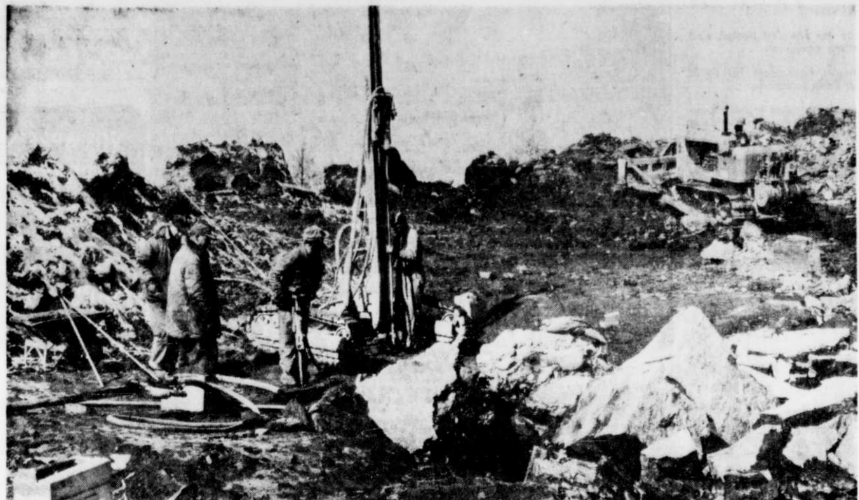
Commencés depuis une semaine et demie, les travaux d'excavation effectués à l'aide d'une perforuse mécanique sur le site du nouveau réservoir du quartier Nord seront terminés cette semaine. (Photo La Tribune)
