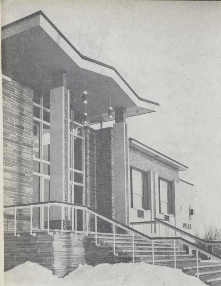
Détail de l'entrée.
