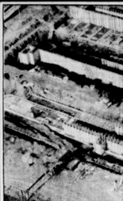
La CUQ achève la construction de deux stations de traitement des eaux usées évaluées autour de quelque 350 millions $.
