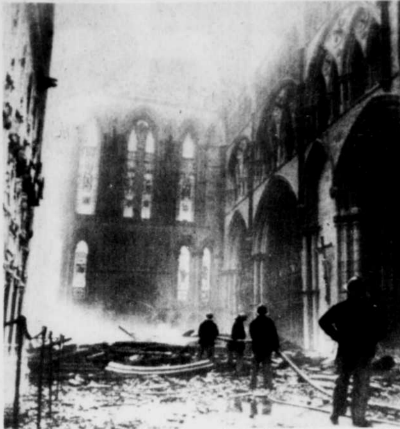
Des pompiers arrosaient, hier matin, les débris fumants de l'aile sud de la cathédrale de York ravagée par un incendie provoqué par la foudre.
