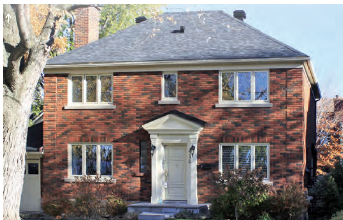
Maison de type King's Cottage Source : Ville de Saint-Lambert
