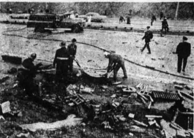
Les pompiers et employés de la Voirie provinciale s'affairent à nettoyer les abords de l'entrée du pont-tunnel.
