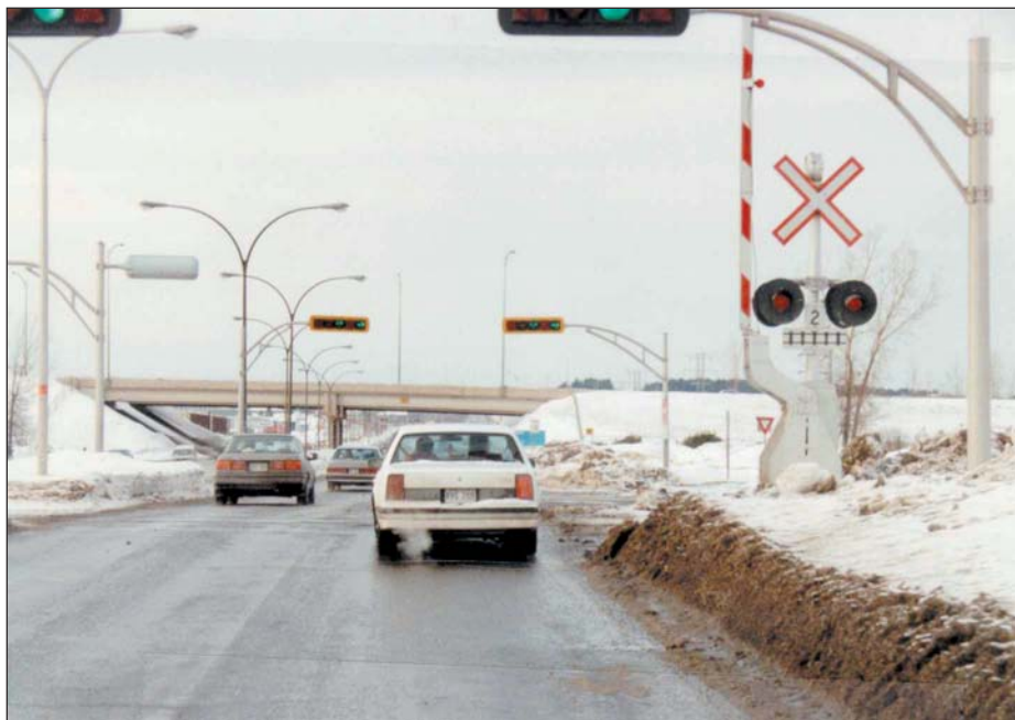
Figure 7-12 Passage à niveau avec barrière
