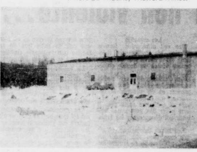
De l'extérieur, le Pavillon Professionnel de la Régionale de l'Amiante ressemble plus à un hangar qu'à une école. Il ne faut toutefois pas se fier aux apparences, car l'intérieur est déjà très bien aménagé même si les travaux ne sont pas complètement terminés.
