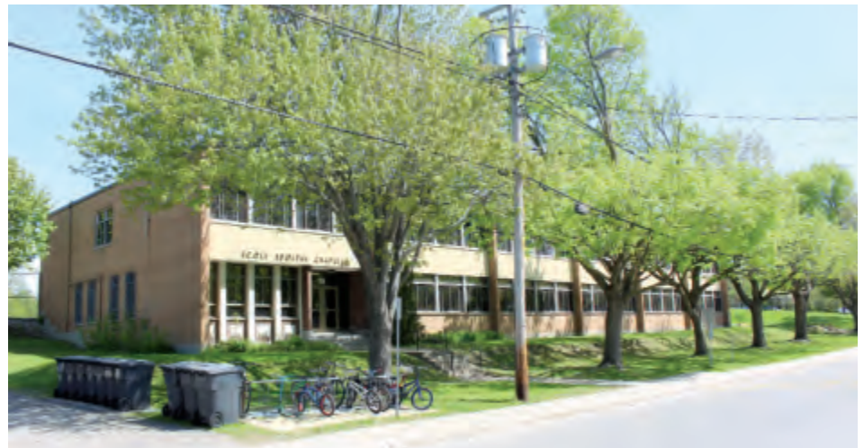
Photo Claude Desjardins À Sainte-Thérèse, les écoles du Trait-d'Union, pavillon Adolphe-Chapleau, sur la photo, et Terre-Soleil seront démolies et reconstruites.
