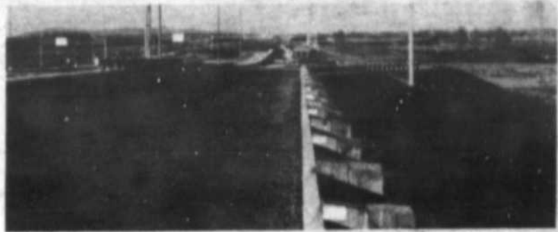
Il ne manque plus que la dernière couche d'asphalte à l'autoroute 30 qui reliera le boulevard Cousineau de Saint-Hubert à l'autoroute 10.
