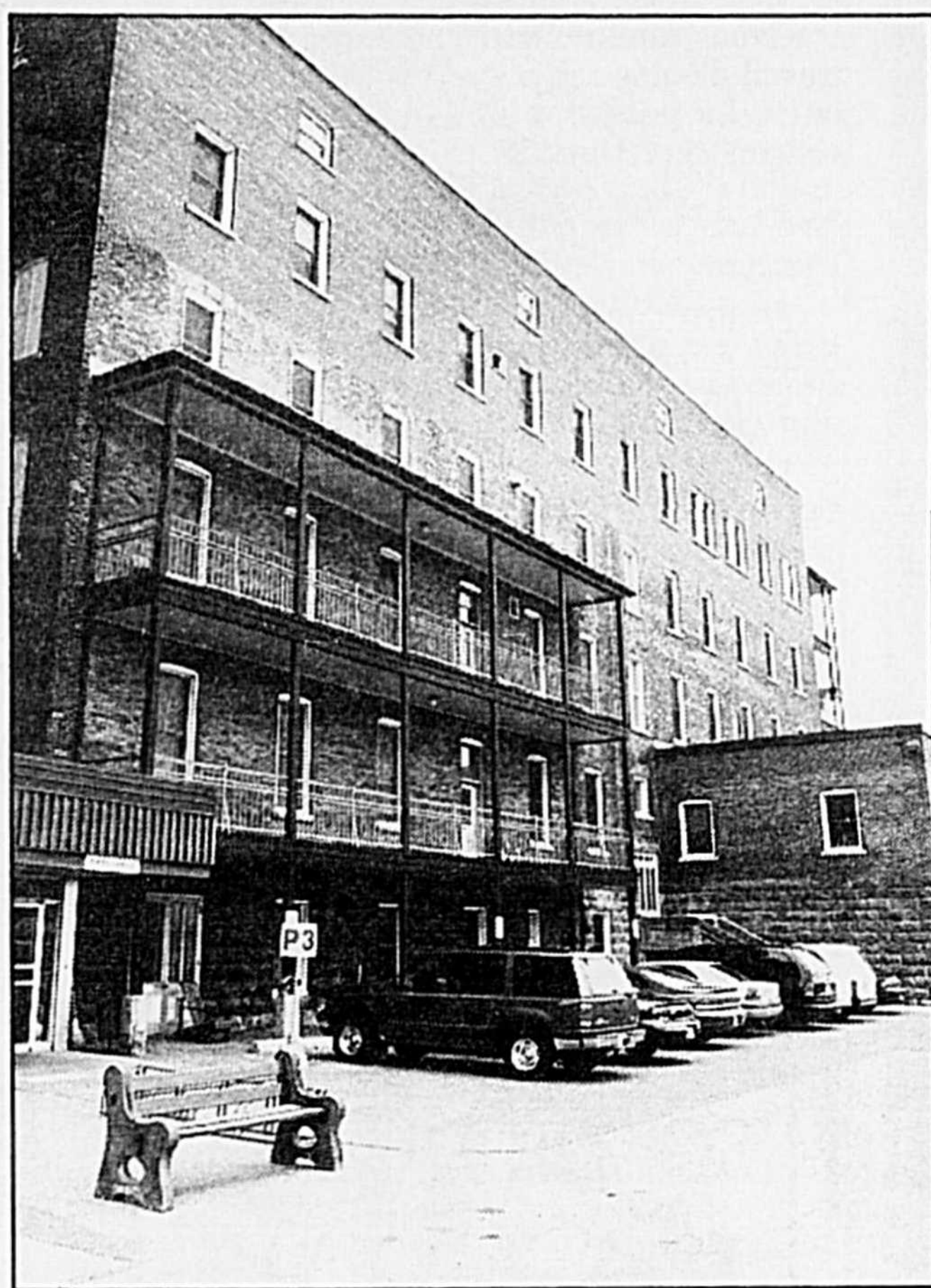
L'Hôtel-Dieu commence à livrer ses vieux secrets, comme la présence d'amiante, aux experts engagés pour préparer les travaux de rénovation.
