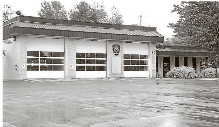
Le service des incendies possède trois casernes, dont celle du boulevard Bromont qui est devenue désuète au fil du temps. — PHOTO JANICK MAROIS
