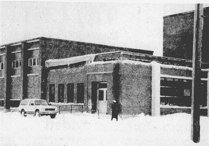
La Commission scolaire a décidé de procéder à l'installation d'une corniche pour remplacer la marquise. Le contrat a été donné en ce sens.
