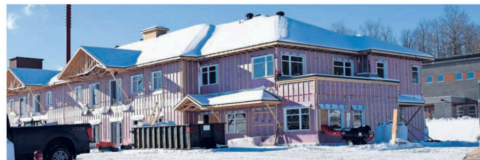
En 2019, s'ajoutera un immeuble de 16 logements sur l'ancien emplacement de l'hôpital Saint-Julien. La Villa du versant du lac offrira des logements pour les aînés dans le cadre du programme Accès logis du gouvernement du Québec. (Photo gracieuSeté)
