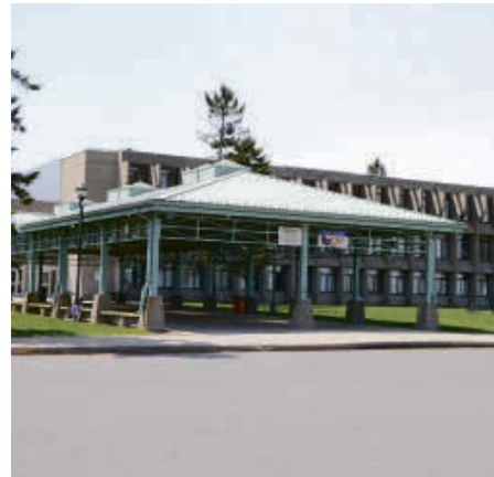
L'école secondaire Fernand-Lefebvre fait partie des bâtiments avec une cote E.
