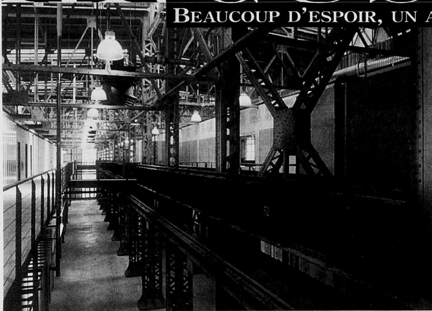
La Halle industrielle Angus, une réalisation de la firme d'architectes Dupuis Dubuc et associés
