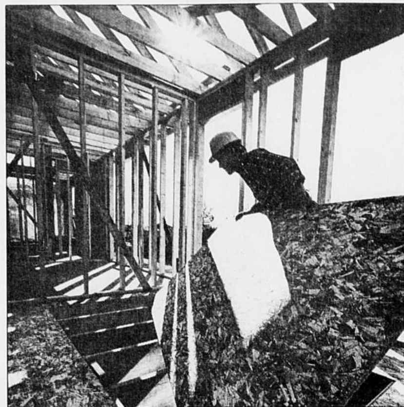
Les mises en chantier ont progressé de 18 % en juin au Québec, contrairement à la tendance canadienne.
