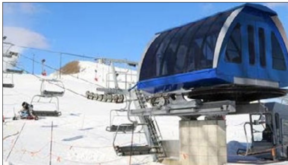
La remontée sera prête pour l'ouverture de la saison en novembre.
