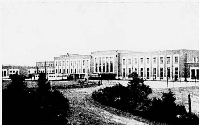
La nouvelle gare. Façade et place de stationnement.
