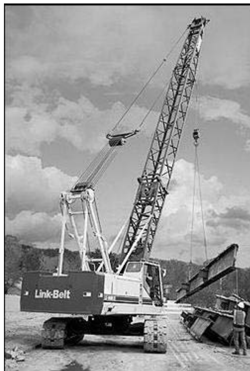
Figure 1 - Grue automotrice à chenilles et à flèche à treillis de forte capacité
