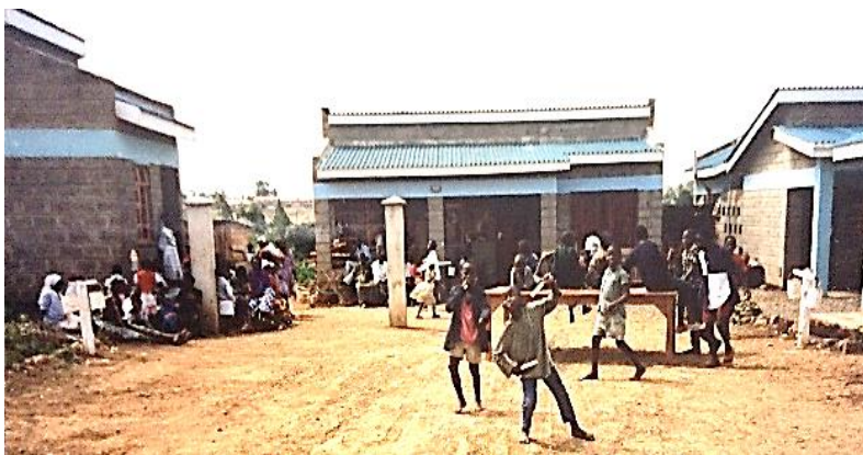
Vue partielle des bâtiments de KWETU
