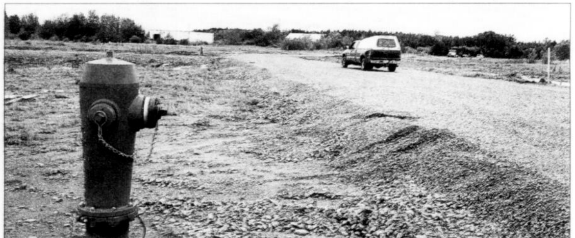
La Ville a acheté les terrains au coût d'un million de dollars il y a un an et, depuis, elle a investi 1,6 million $ pour préparer les rues et amener les différents services.
