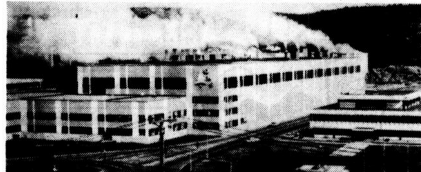
N'est été de la clairvoyance des sapeurs-pompiers et des équipes techniques de Q.n.s., toute l'usine aurait pu y passer dans cet incendie. (photo archives).
