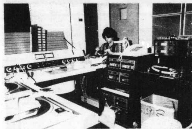
Il y a quelques jours à peine, une équipe de techniciens dont celui-ci, complétait l'installation de pièces d'équipement.
