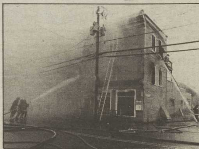
Les enquêteurs n'ont pu déterminer la cause exacte de l'incendie qui a détruit l'édifice Robb, à Knowlton, mais ils écartent toute possibilité d'un incendie criminel.
