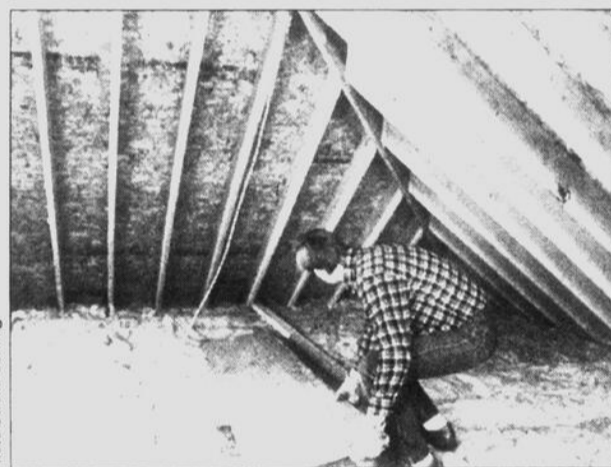
L'entretroit est un bon endroit pour commencer les travaux d'isolation.
