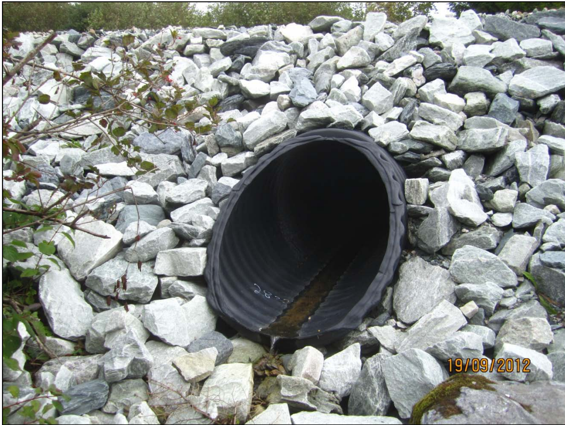
Figure 9 Ponceau aménagé dans le cadre du projet d'éoliennes
