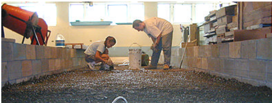
Figure 62 : Épandage du coulis de ciment sur le gravier
