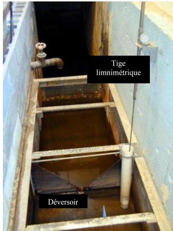
Figure 69 : Déversoir du côté de la plaine et tige limnimétrique
