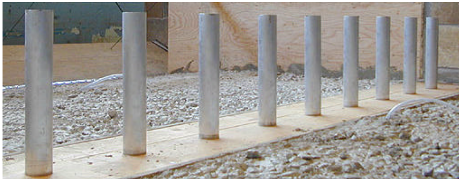
Figure 64 : Base de support des piliers
