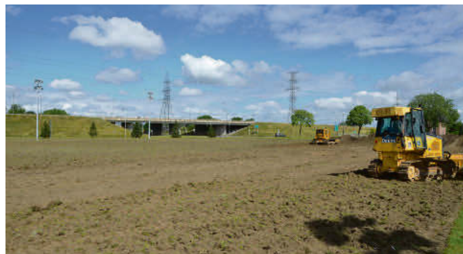
Les travaux vont déjà bon train aux abords de l'École secondaire Bernard-Gariépy. Photo Alexandre Brouillard | Les 2 Rives ©
