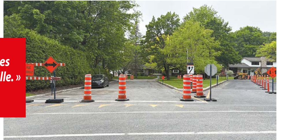
La Ville entreprend des travaux de pavage sur un tronçon de la rue Edgewood. (Photo : Frank Jr Rodi)
