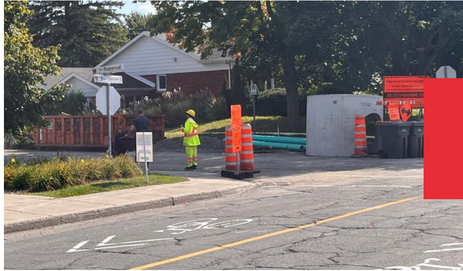
Des travaux d'ampleur sont à prévoir à Saint-Bruno-de-Montarville. (Photo : Frank Jr Rodi)
