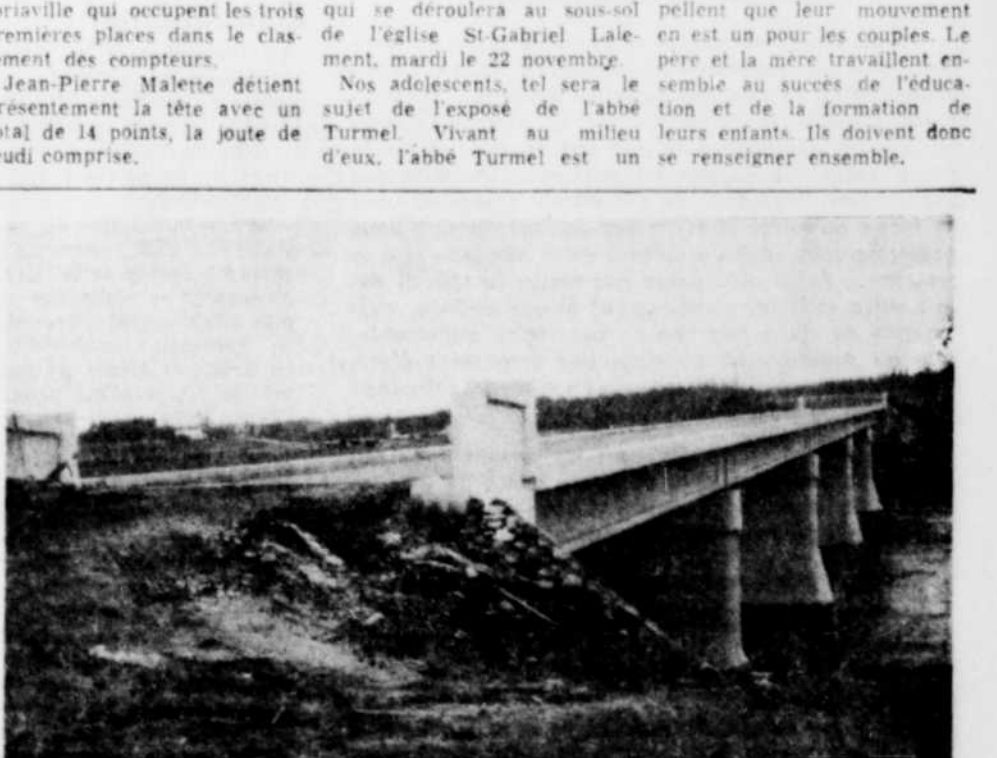
ON PEUT maintenant circuler sur le nouveau pont de St-Louis de Blandford. Cependant le pont sera officiellement ouvert à la circulation seulement lorsque l'on aura procédé à la pose des garde-fous. Également lorsque le pont sera ouvert une nouvelle route atteindra des deux côtés. Ce nouveau tronçon de route sera en gravier cette année mais asphalté l'an prochain, tout probablement. En empruntant le pont et la nouvelle route, les automobilistes sauveront quelques minutes en évitant complètement le village de St-Louis. La construction de ce nouveau pont à St-Louis constitue une des améliorations d'importance effectuées dans le secteur de la voirie pour le comté d'Arthabaska en 1966.
