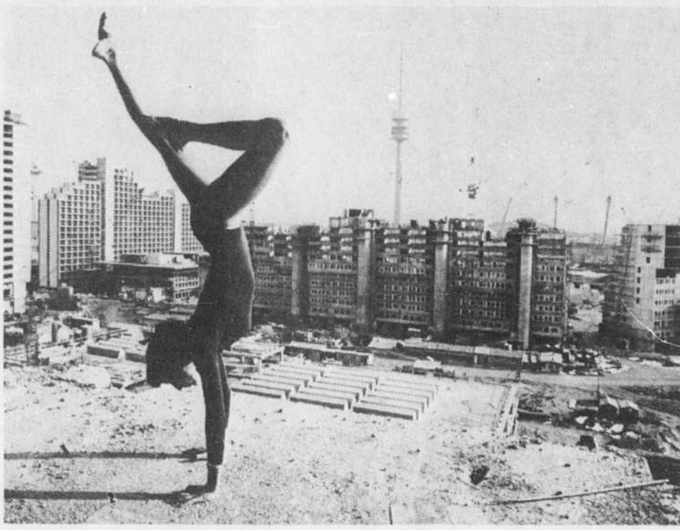
QUESTION DE STIMULER LES OUVRIERS! Ce ne sont pas encore les espoirs olympiques de Munich, comme Margareta Probst (17 ans), qui font de la gymnastique au village olympique, mais bien les ouvriers du bâtiment. Néanmoins, le gros-œuvre est presque achevé et l'aménagement intérieur est commencé. (Photo Olympia Press)
