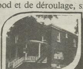
115, rue Saint-Louis, Warwick 6 logements
