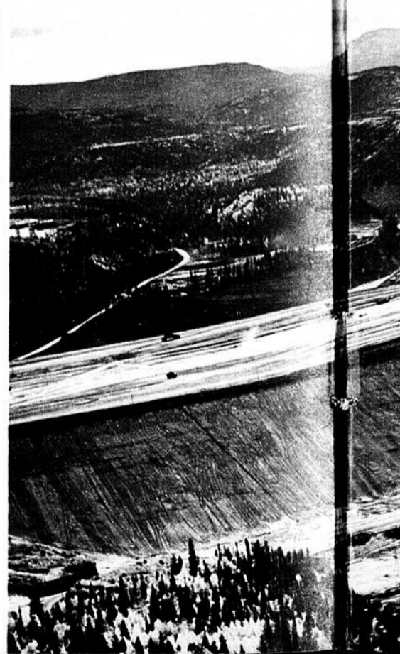
COLOMBIE: le barrage de Portage Mountain, sur la rivière-à-la-Paix.
