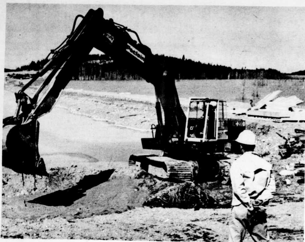
A L'AIDE D'UNE GRUE et sous la surveillance de M. Patrick Mercier, contremaître aux bassins de sédimentation, on récupère la boue à l'intérieur du bassin.
