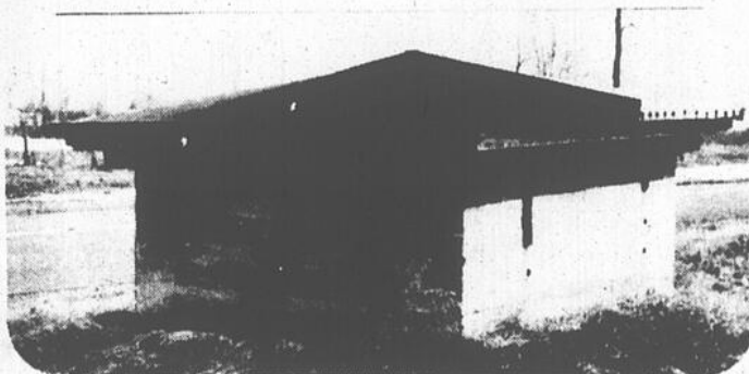
Ce puits avait été construit par quatre preneurs, il y a de cela 35 ans. Aujourd'hui, l'eau que l'on y retrouve peut servir aux animaux et au lavage domestique mais est impropre à la consommation.
