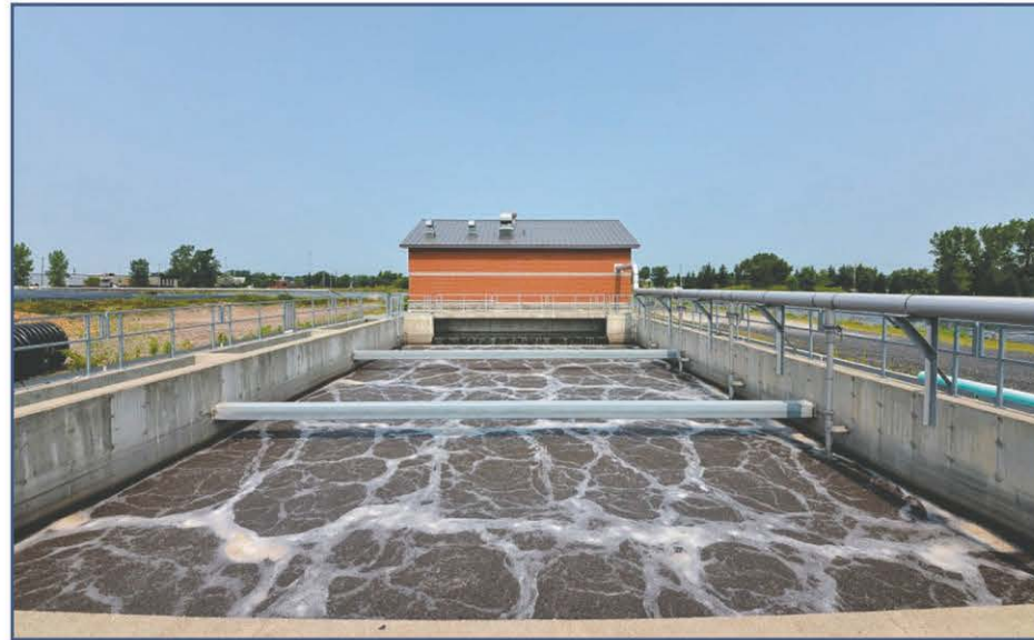
Le conseil a adopté des règlements pour autoriser des travaux de mise en place d'un système de désinfection à l'usine d'épuration pour 1 900 000 $.
