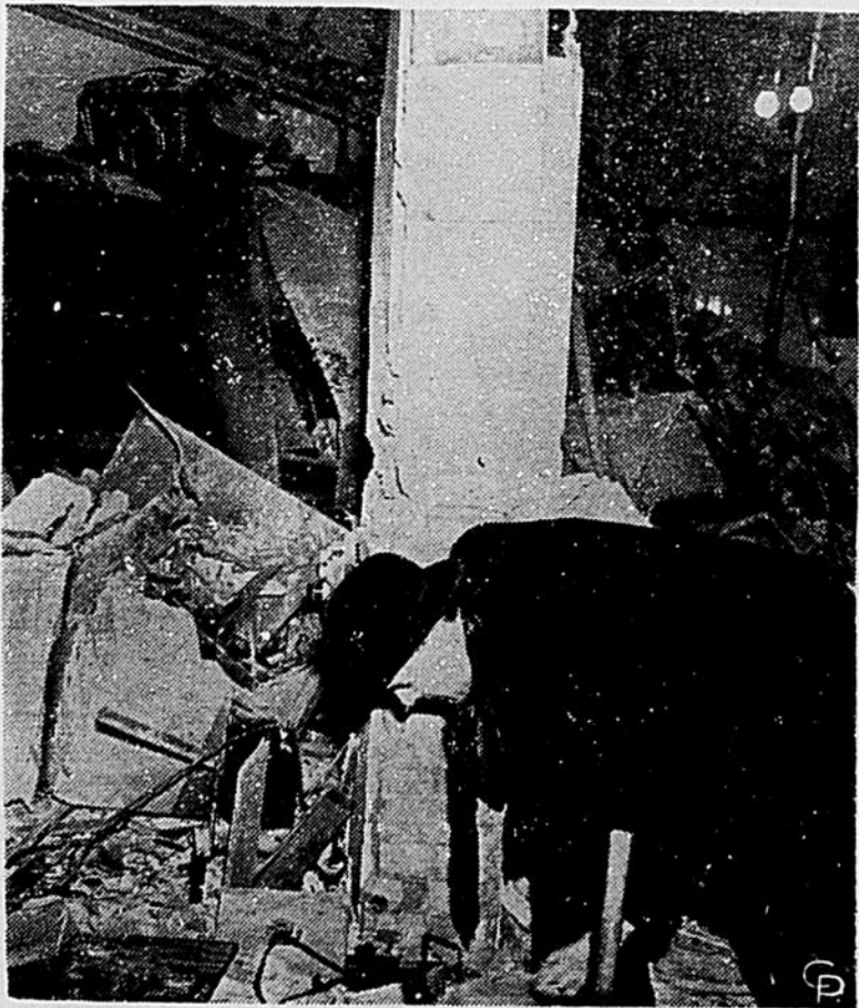
• L'OEUVRE DES DYNAMITARDS A LONDRES: Six personnes furent blessées dans la station de Leicester Square du chemin de fer souterrain, à Londres, au cours d'une explosion que l'on impute aux terroristes irlandais qui sèment la panique depuis déjà quelque temps dans la capitale du Royaume-Uni.
