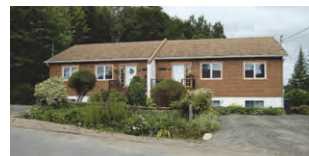
SAINTE-AGATHE-DES-MONTS 169 000 $ Très beau jumelé, avec grandes pièces à aire ouverte et très lumineux. 2 chambres à coucher et possibilité d'une 3e, grande salle familiale au sous-sol avec entrée indépendante. Possibilité de finir le sous-sol en unité de revenu. Situé dans un secteur tranquille à proximité des services. MLS 23077202
