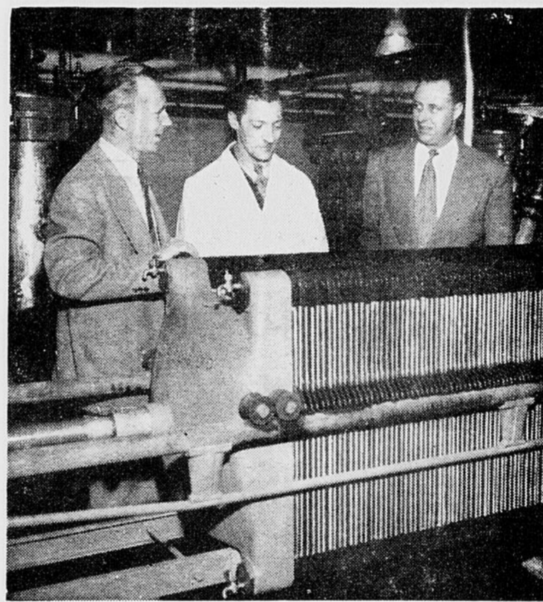
On voit ci-haut une partie de la chambre de filtrage la plus moderne de toute brasserie en Amérique; celle de la nouvelle brasserie Carling à Montréal. A l'avant-plan, le filtre proprement dit, qui est de la conception la plus récente; il est unique dans la pro-
