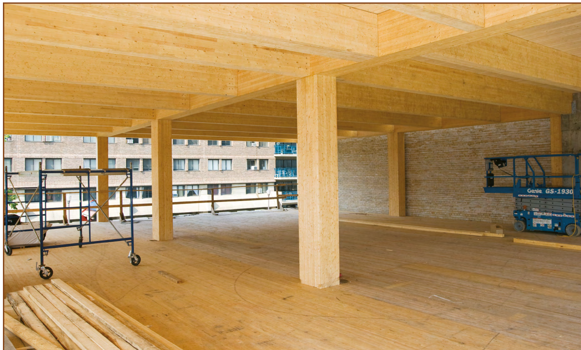
Figure 8 – Assemblages et attaches métalliques recouverts de bois avant encapsulation
