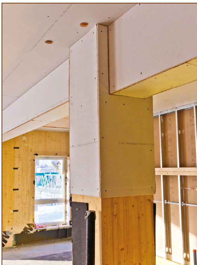
Figure 13 – Installation de la première couche d'encapsulation (photo : J.-F. Grandmont, 2017)
