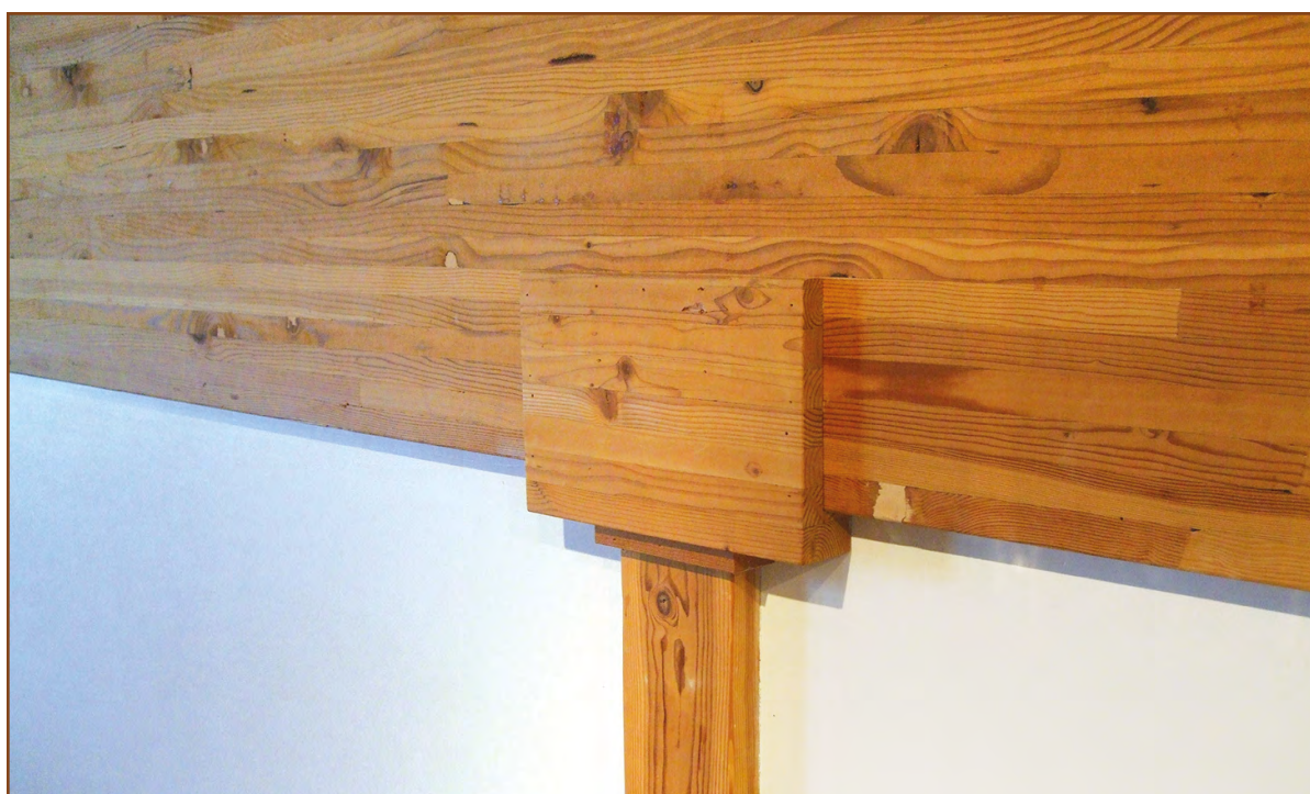
Figure 8 – Assemblages et attaches métalliques recouverts de bois avant encapsulation
