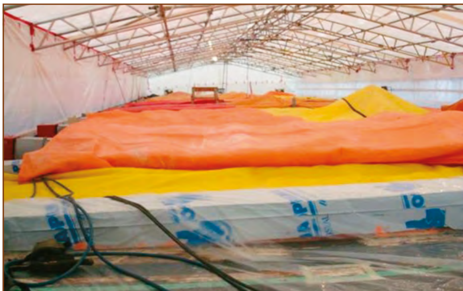
Figure 32 – Utilisation de couvertures chauffantes pour favoriser le séchage des éléments de toiture lorsque les conditions ambiantes ne sont pas favorables (source : Wang [29])
