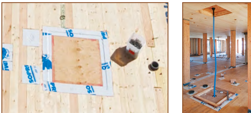
Figure 35 – Protection des ouvertures lors de la construction (source : GHL Consultants Ltd.)
