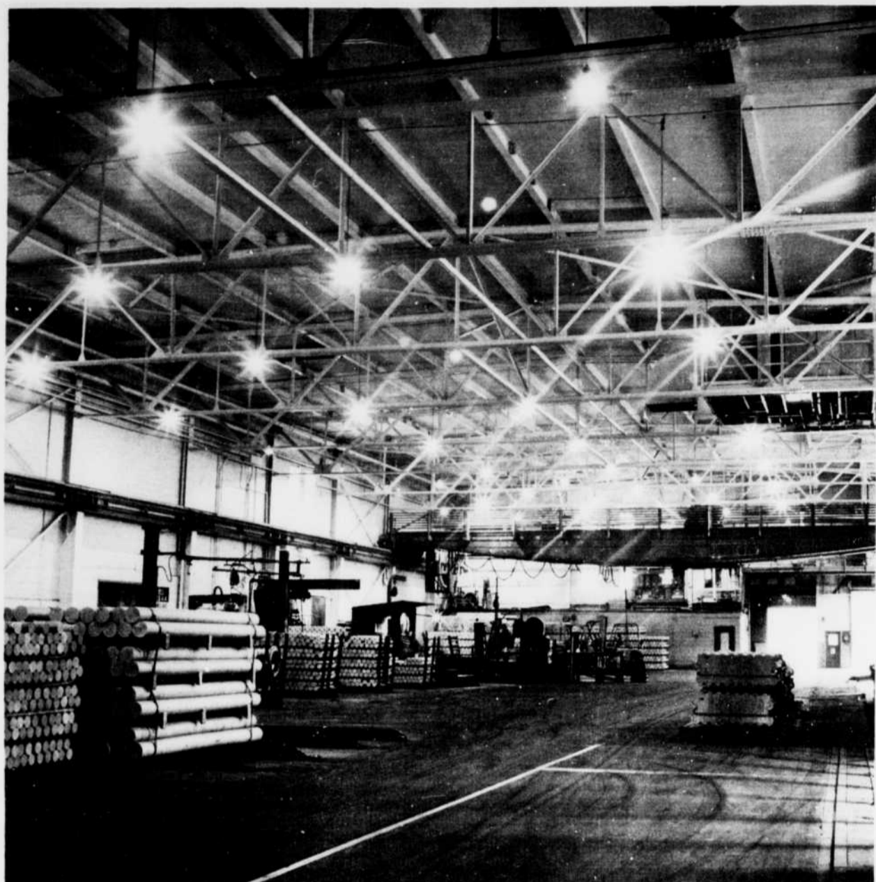
UNE ECLATANTE REALISATION - Le programme de peinture au Centre de coulée Arvida est en marche. Déjà, l'extrémité Est de l'usine de coulage 2 a été rafraîchie, ce qui lui confère un air de propreté et d'ordre. Les employés y trouvent désormais une ambiance nettement supérieure pour le travail.
