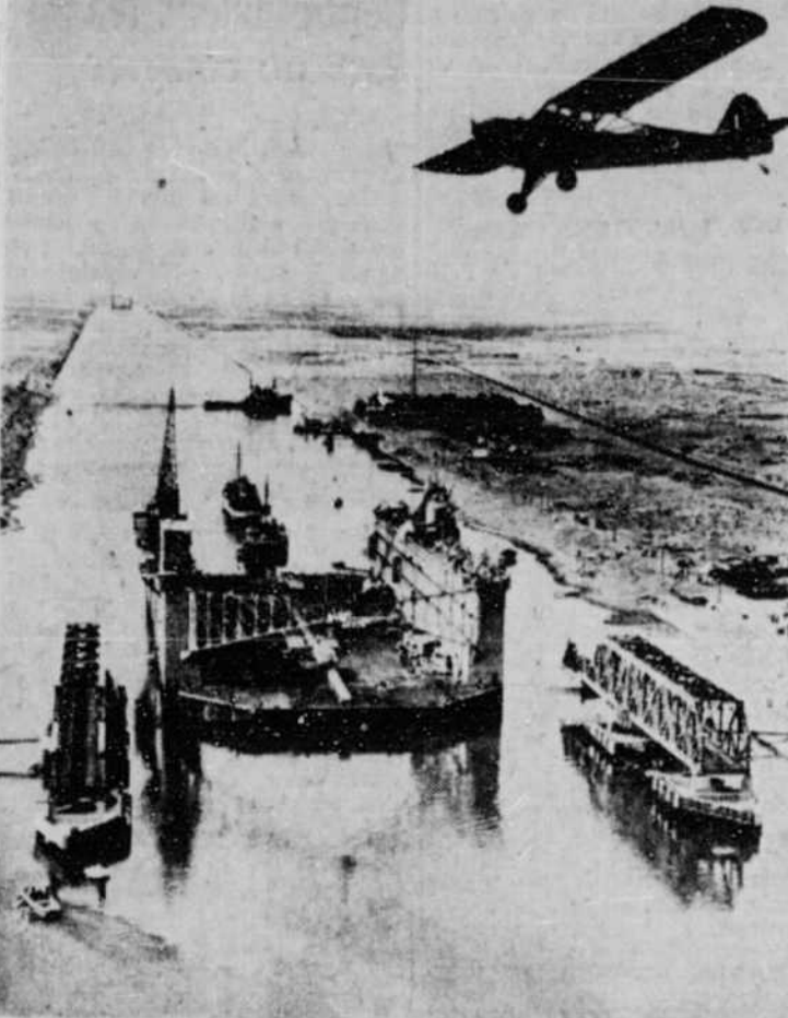
Le plus grande cale sèche flottante britannique, récemment complétée à Bombay, vient d'entreprendre un grand voyage. Elle se rend présentement à Malte, traînée par des remorqueurs de l'Armada. Pour cette longue promenade, la cale sèche a été séparée en deux pour traverser le canal de Suez où cette photo fut prise. On en voit ci-dessus une section. La cale sèche mesure 885 pieds de long, 172 de large, et 75 de haut et peut recevoir des navires de 50,000 tonnes. Elle a coûté $4,500,000. (Acme)
