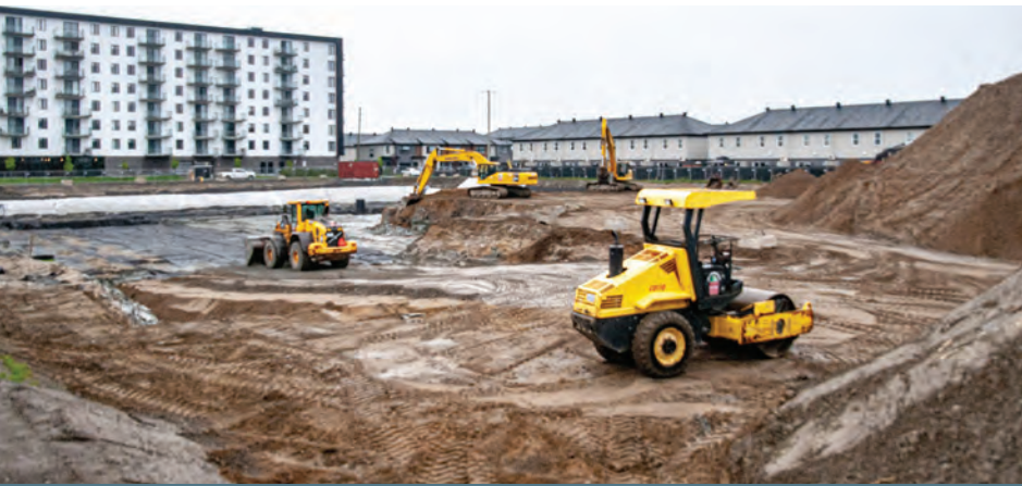
Photo : Maxime Labelle Les premiers occupants devrait emménager à l'été 2024.
