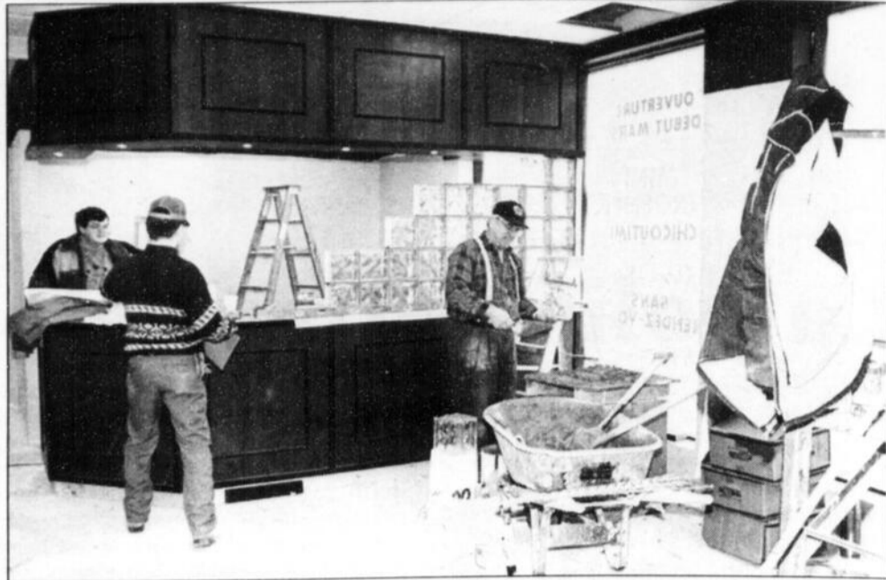
OUVERTURE - L'ouverture de la mini-urgence se fera le 18 mars. Ici, des ouvriers terminent l'aménagement de la salle d'accueil.
